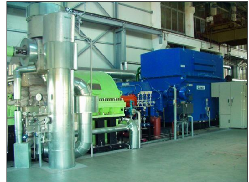
Парова турбіна SST-300 з турбогенератором
