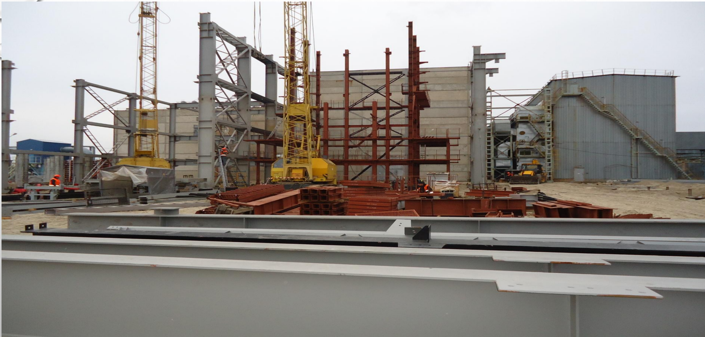
Монтаж котла КВ-Г-116,3-150 на котельной жилмассива Позняки. г.Киев ноябрь 2016г.
