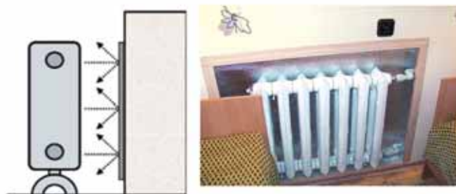
Рисунок 2.18 – Влаштування відзеркалювального екрану на зарядіаторній ділянці стіни
