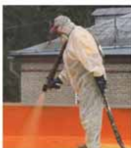
Рисунок 2.9 – Використання методу утеплення напіленням пінополіуретаном а) при реконструкції плоских дахів
