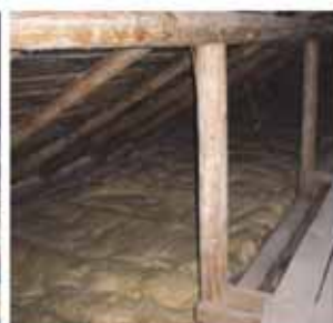
Рисунок 2.10 – Утеплення горища мінераловатними плитами
