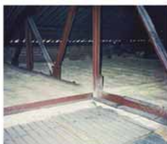
Рисунок 2.9 – Використання методу утеплення напіленням пінополіуретаном а) при реконструкції плоских дахів
