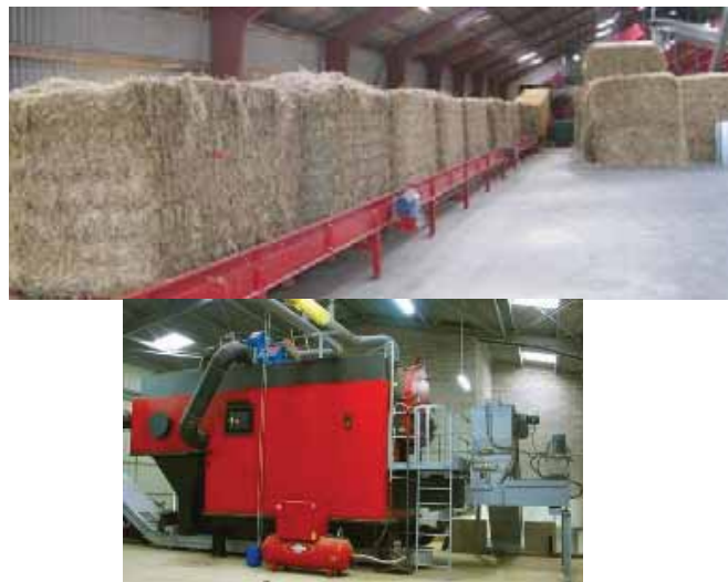
Рисунок 3.3 – Один із варіантів біокотла, що використовує тюковану соломі в якості палива з лінією подачі соломи
