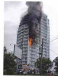
Рисунок 2.4 – Поширення вогню по поверхні пінополістиролу
