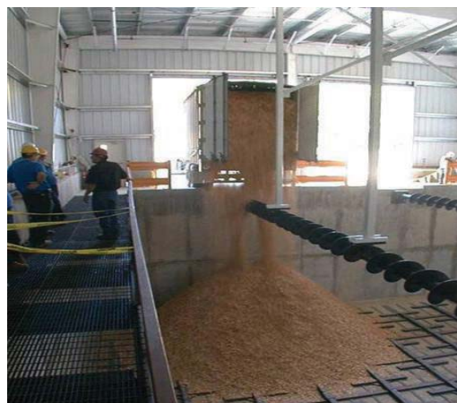
Рисунок 2.18 – Бункер-накопичувач деревної тріски та подрібненої соломи із системою гідравлічного ворухіння біопалива
