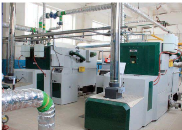
Рисунок 2.14 – Загальний вигляд теплогенеруючого устаткування біокотельні
