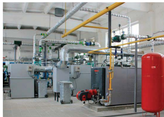
Рисунок 2.14 – Загальний вигляд теплогенеруючого устаткування біокотельні
