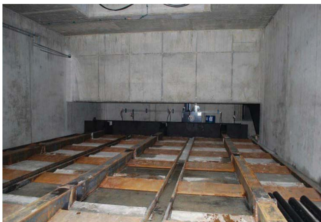
Рисунок 2.18 – Бункер-накопичувач деревної тріски та подрібненої соломи із системою гідравлічного ворухіння біопалива
