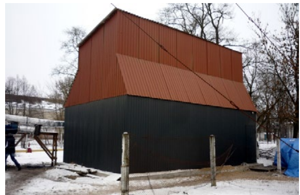
б) модульна котельня на гранулах
