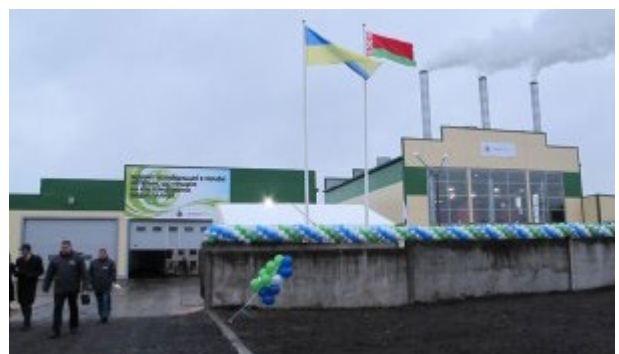
Рис. 4.7. Котельня в м. Славутич.
