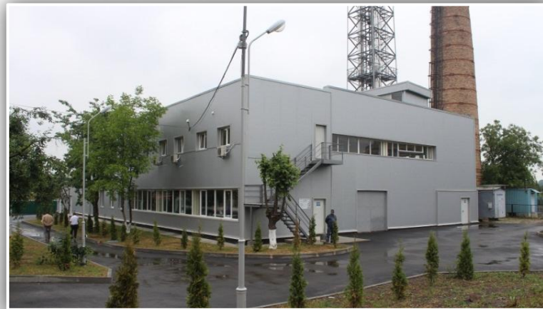
вул.Баженова, 15а (газова кот.)
