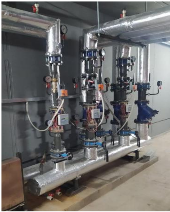
Рис. 4.7 Тепловий пункт
