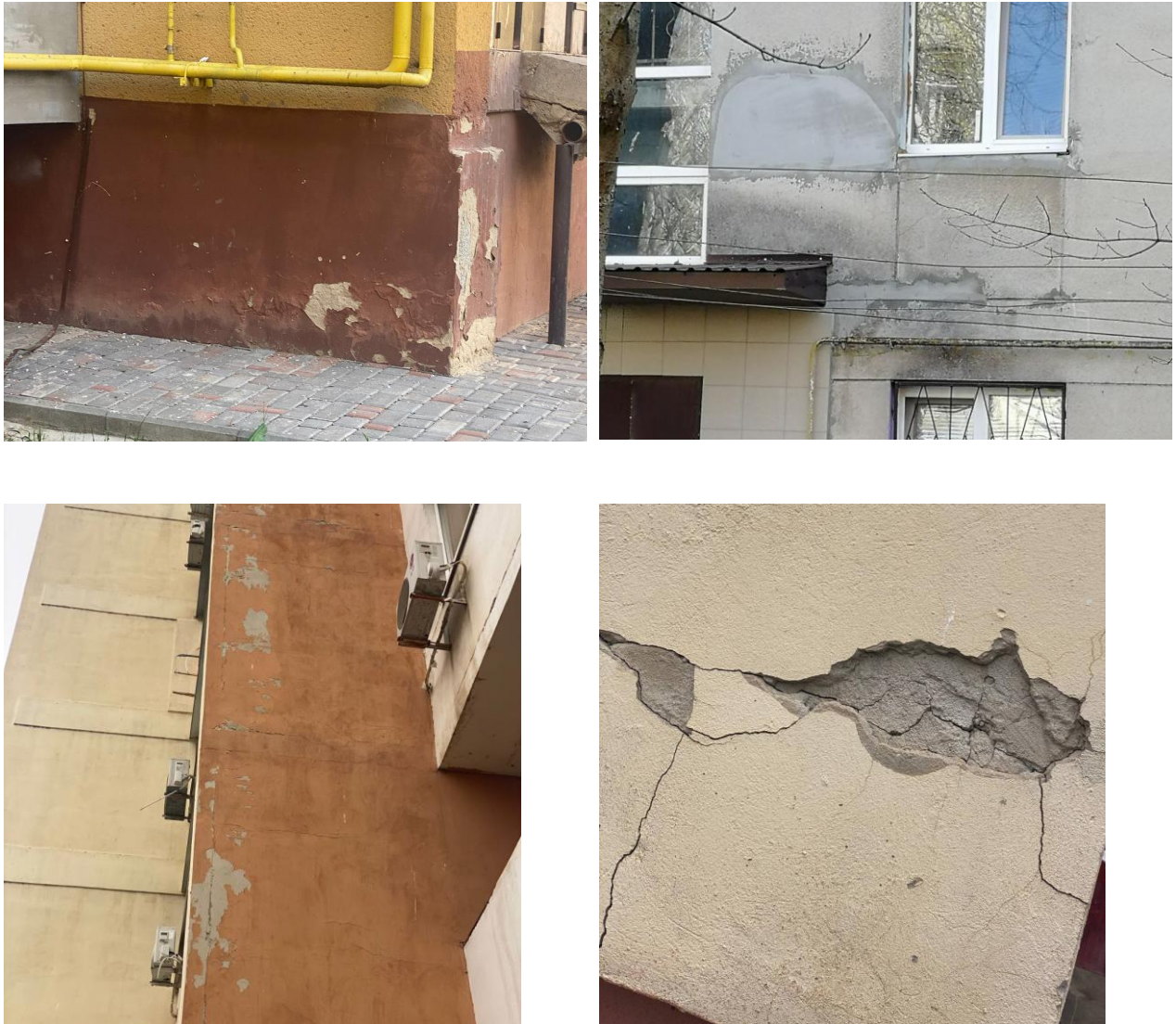
Рис. 4.3 Приклади порушення стін та оздоблення
