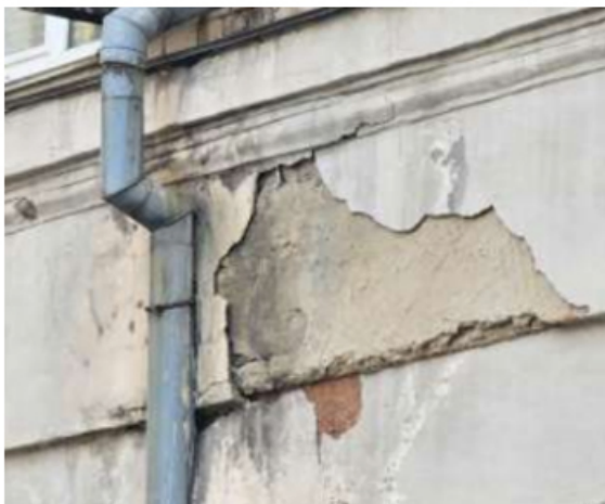
Рисунок 17. Приклади пошкоджень на фасаді будівлі
